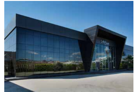
Selüz Kimya Fabrikası Kocaeli
